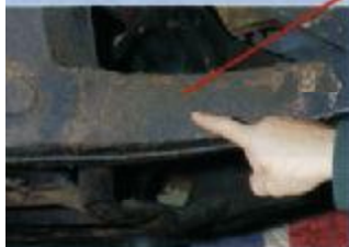
Fallschaden? Untersuchen Sie in geschwungenen Rahmenträger
